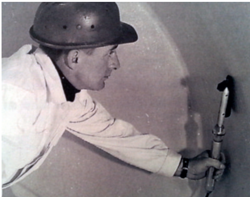
▲ Prüfung der Porenfreiheit Tankinnenbeschichtung
