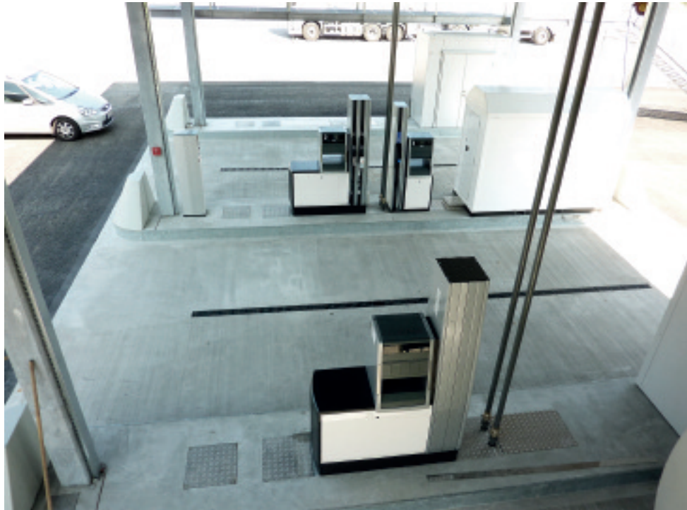
▲ Tankstelle mit WAYNE Helix 6000 Zapfsäule und AdBlue-Container
