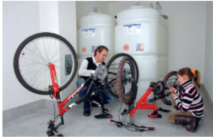
▲ Mehr Platz im Keller dank platzsparender moderner Öltanks
