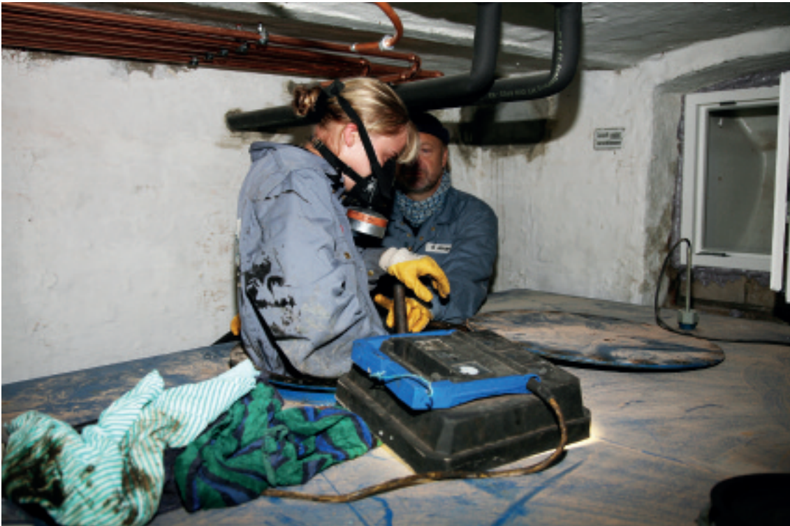
▲ Tankreinigung Kellertank
