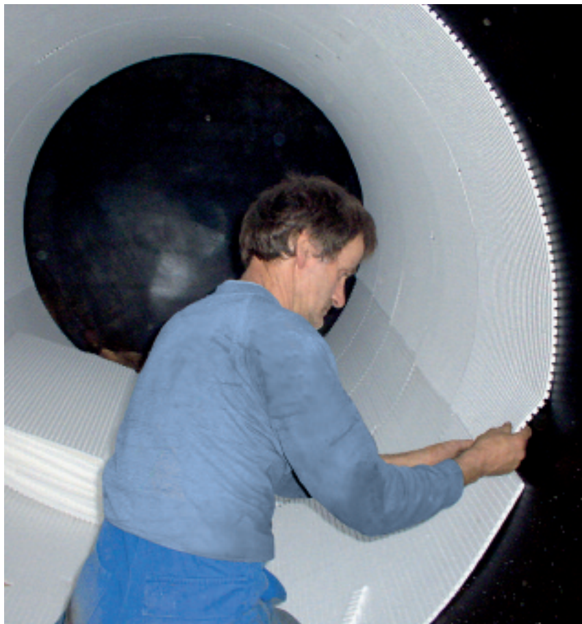
▲ Einbau einer Zwischenlage vor der Montage einer Tank-Innenhülle
