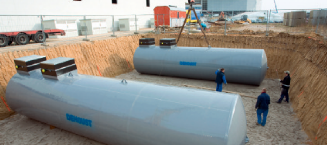
▲ Zylindrische Lagerbehälter mit Endoprene Außenbeschichtung
