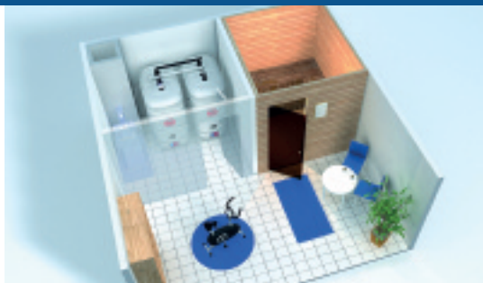
▲ Die Unterbringung moderner Öltanks im Haus ist flexibel – dank Geruchssperre und Doppelwandigkeit.
