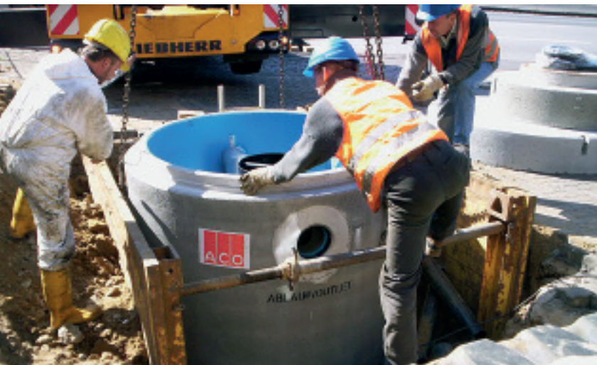
▲ Abscheider-Einbau
